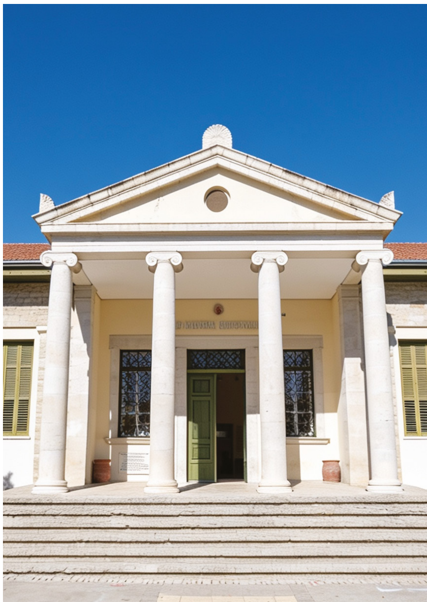
Κτήριο «Ανδρέας Θεμιστοκλέους» στη Λεμεσό
